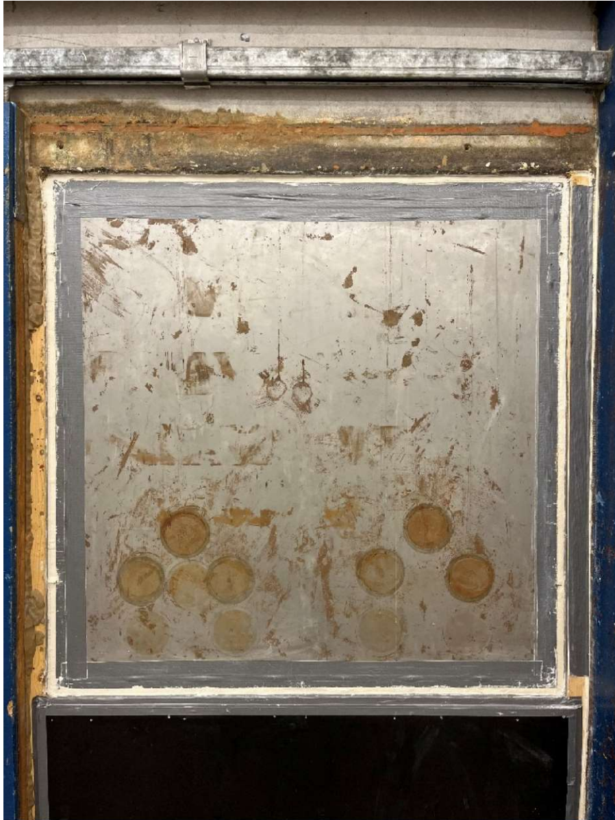
Figur 2: Fogen av brandskyddsmassa (vit) vid enkelsidig applicering (orienterad mot mottagarrummet för ljud)
