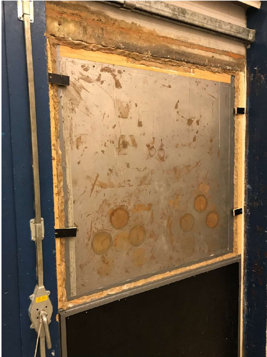
Figur 5: Inför provmätning på referensfallet tätning av springan med lera (se Bilaga 2).
