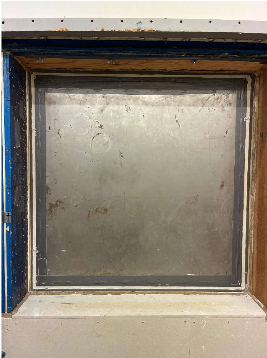
Figur 3: Fogen av brandskyddsmassa (vit) vid dubbelsidig applicering (orienterad mot sändarrummet för ljud)
